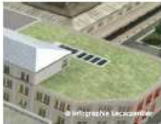
Panneaux solaires thermiques sur le collège
