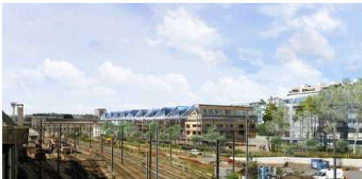
Fig. 26 - ZAC Pajol, Paris 18 ème © Jourda Architectes Paris, 2009. La halle Pajol, témoin du passé industriel du site, est conservée et réhabilitée.
