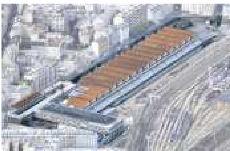
Fig. 47 – Vue aérienne de la halle Pajol
