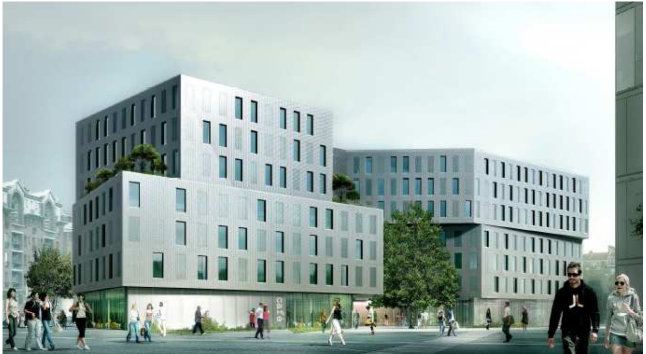
Fig. 29 – Eco-quartier de la gare de Rungis, Paris 13 ème © Atelier Christian Hauvette architectes Paris 2009. Les logements pour étudiants et chercheurs proposent des toitures-jardins accessibles au public. Ces espaces sont conçus pour limiter les effets de l'îlot de chaleur et mieux isoler le bâtiment.
