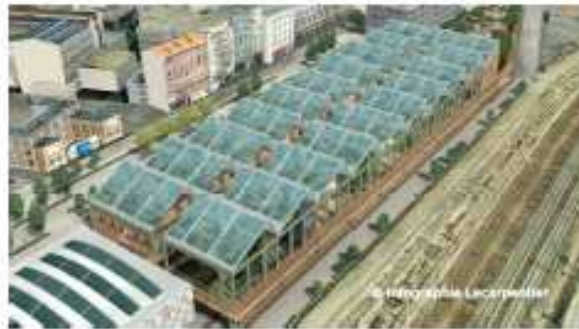
Panneaux solaires photovoltaïques sur la halle et le centre sportif
