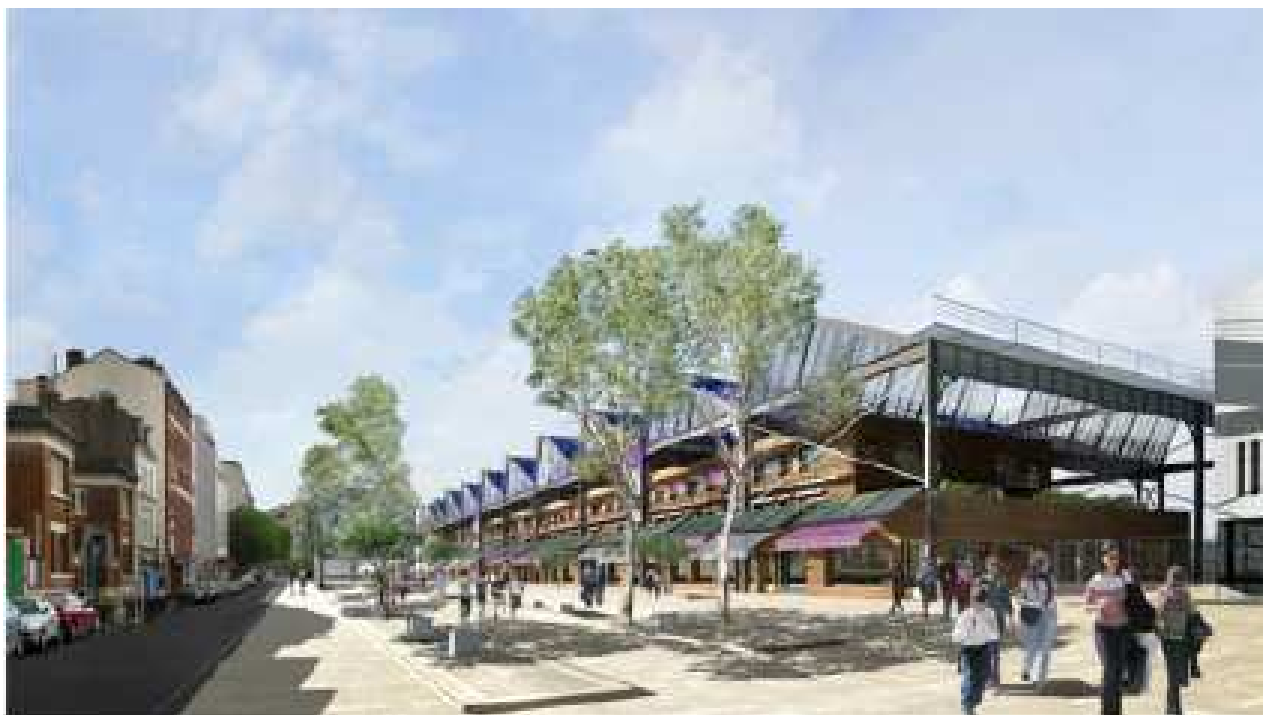
Fig. 30 - ZAC Pajol, Paris 18 ème , centrale photovoltaïque de la grande halle © Jourda Architectes Paris, 2009. La toiture de la halle Pajol est couverte de panneaux photovoltaïques et la transforme en centrale solaire photovoltaïque, qui améliore ainsi le bilan énergétique de la ZAC.
