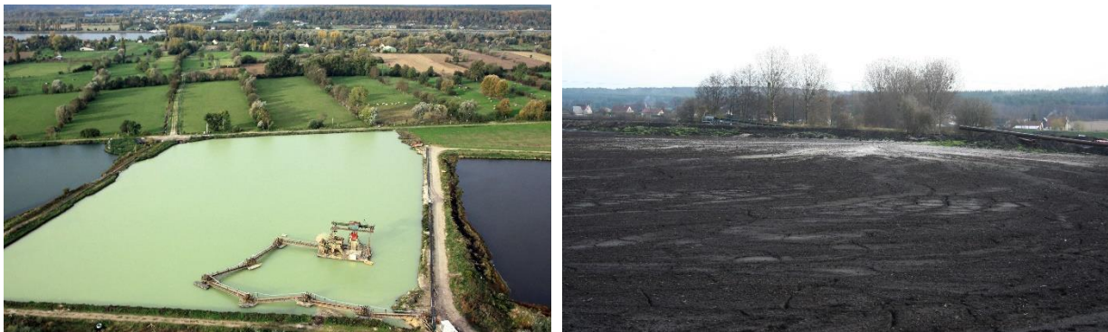
Fig. 37 : Photos montrant une parcelle dont les matériaux tourbeux ont été aspirés (gauche) puis refoulés sur la parcelle restaurée. (© CBN et F. Bureau)
