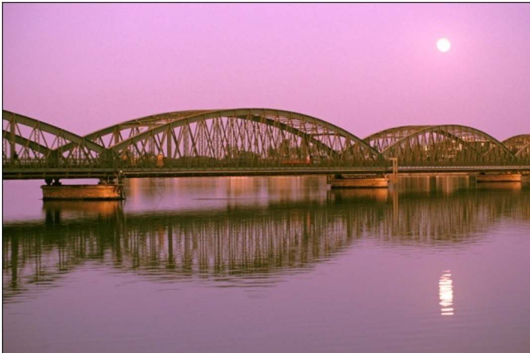
Figure 19: Le pont FAIDHERBE
