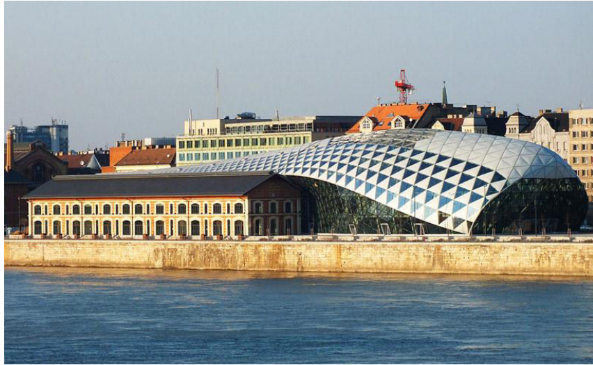
CET building, 2006-2011, Kas Oosterhuis, Budapest, Hongrie. Fig. 27
