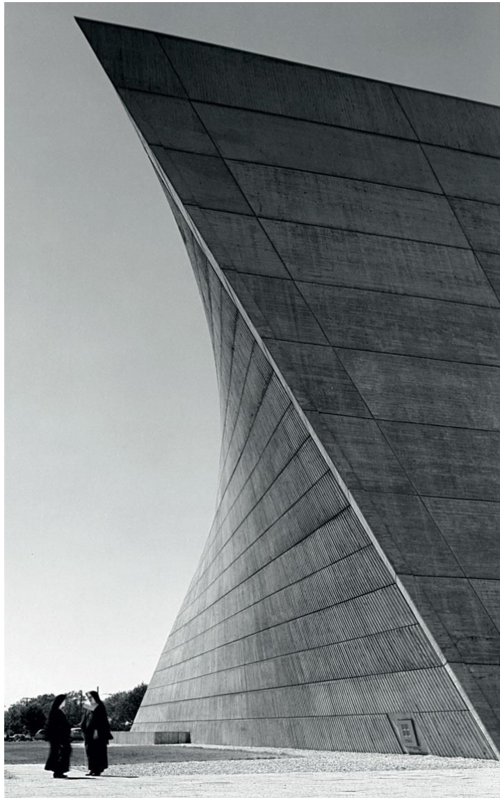
Parois hyperbolique-parabolique en béton armé, Church of St Francis of Sales, 1964-1966, Marcel Breuer (et Herbert Beckhard), Muskegon (Michigan), États-Unis
