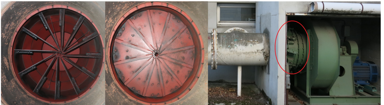
FIGURE 5.3.5 – Système de pales régulant la vitesse de fonctionnement de la soufflerie
