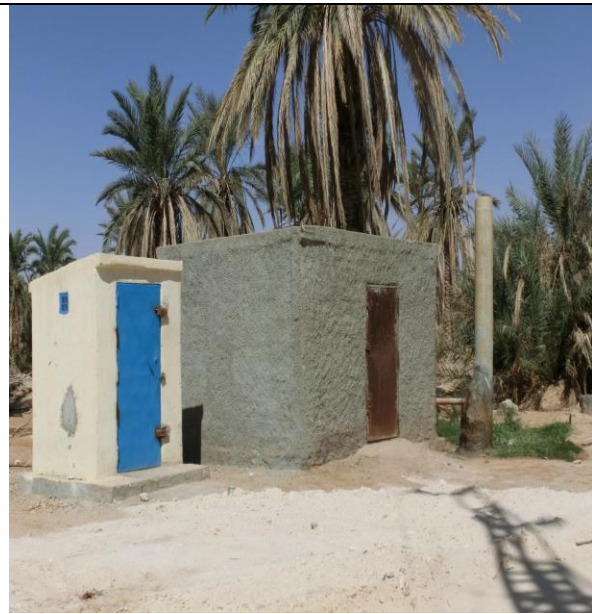
Forage électrifié avec abris de forage
