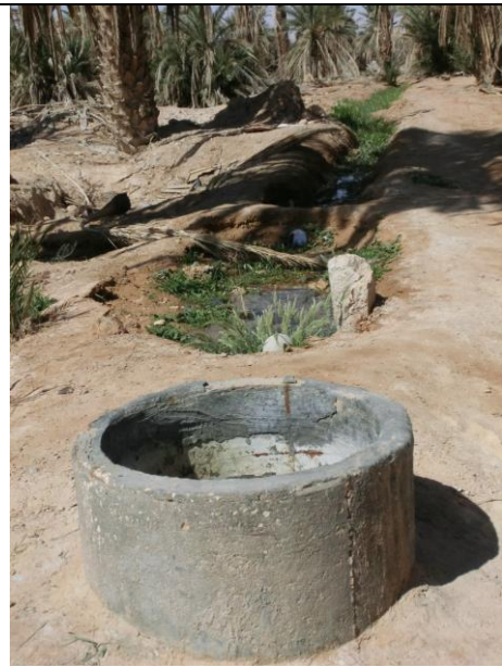
Bassin répartiteur d'eau d'irrigation
