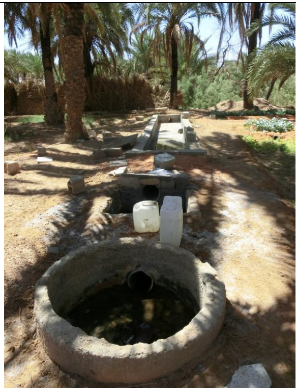
Confection de bassin et seguia en ciment
