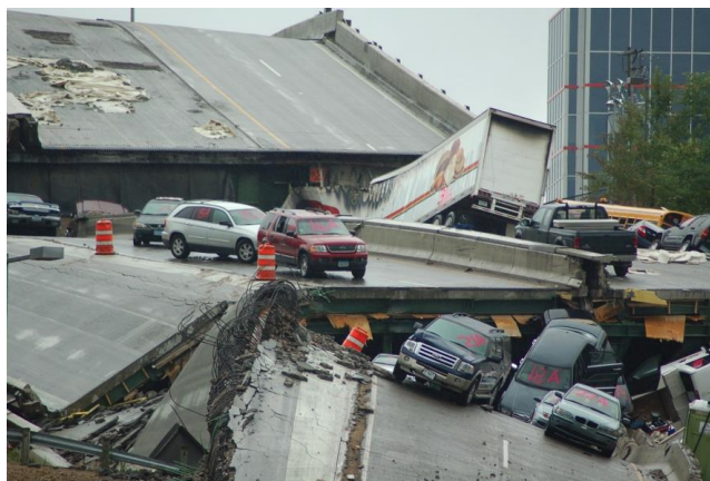
Figure 2 : Effondrement du pont I-35W sur le fleuve Mississippi Source : ABC News
