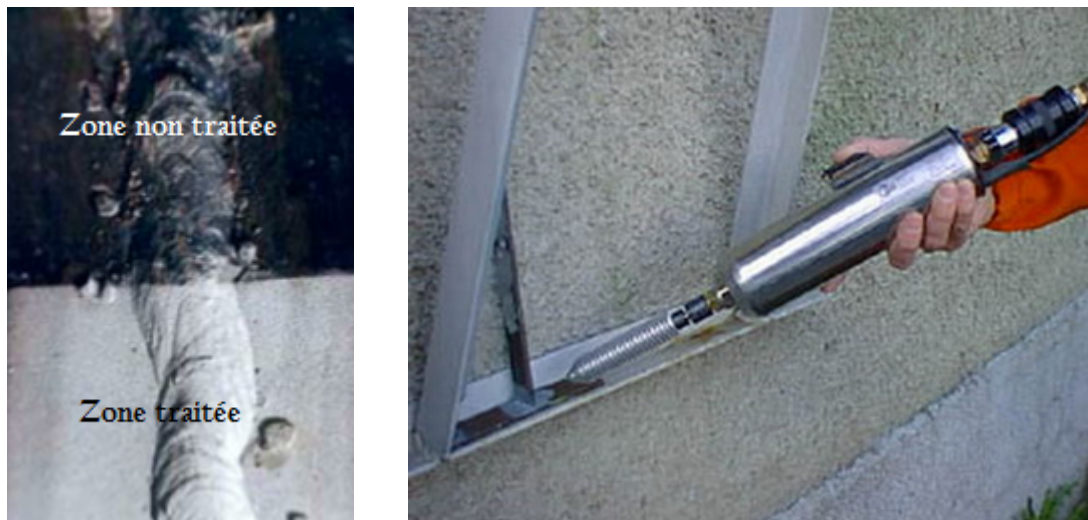
Figure 1.22 : Traitement anticorrosion par dépôt Cold Spray de zinc sur un cordon de soudure (à gauche). Exemple d'un équipement Basse Pression équipé d'une buse spéciale Dycomet optimisée pour le dépôt localisé d'un revêtement de zinc (à droite) [42], [45]
