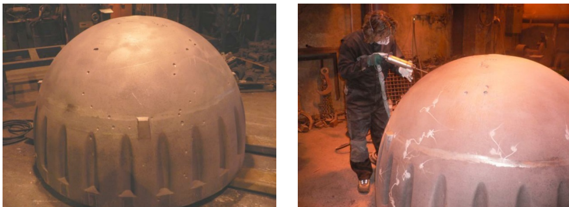
Figure 1.21 : Réparation et rebouchage de trous d'usure sur un moule en fonte par l'utilisation du Cold Spray Basse Pression [42]
