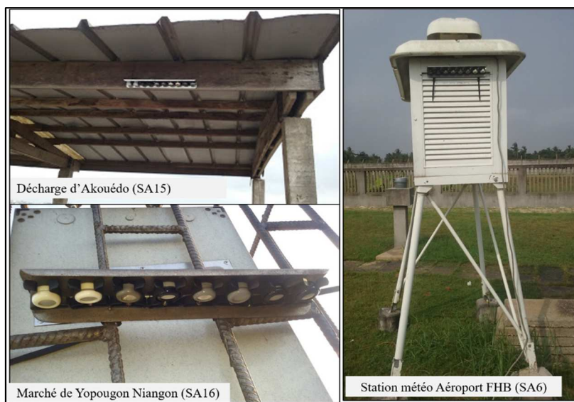
Figure 2.17: Capteurs passifs montés en duplicate sur un rail en inox sur différents sites de mesures : a) à la décharge d'Akouédo, b) au marché de Yopougon Niangon et c) à l'Aéroport FHB.
