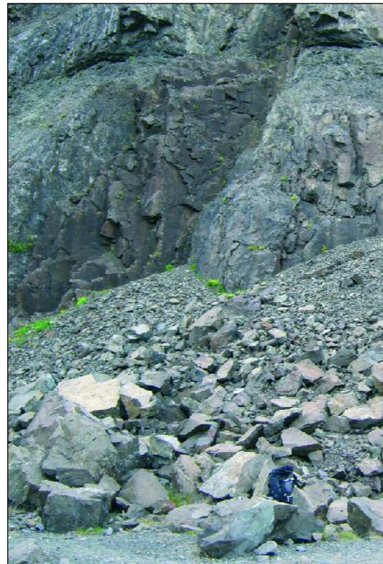
PHOTO 11 – Écroulement sur des tabliers d'éboulis au pied d'une paroi en rive droite de la vallée de la Skaftá.
