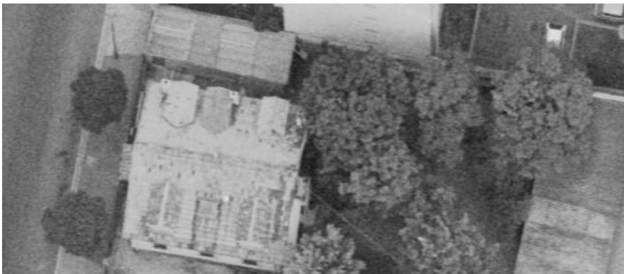
FIG. 1.7 – Un bâtiment paré de ses 6 lucarnes
