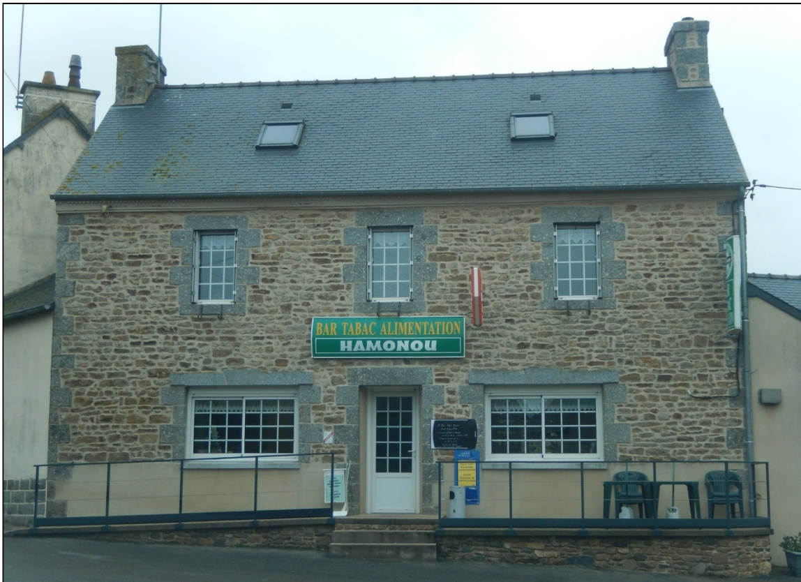
Figure 102 : Le bar-tabac alimentation de Saint-Gildas (photographie : I. Le Clec'h)
