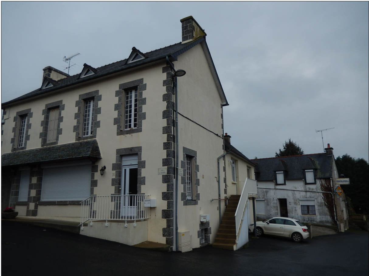
Figure 48 : Deux anciens commerces au Vieux-Bourg transformés en habitations. Au fond, un ancien garage Renault, au premier plan, l'on devine une ancienne vitrine obscurée par des volets. (Photographie : I. Le Clec'h)
