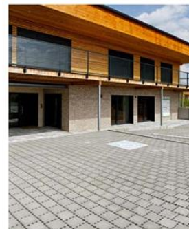
Parking de l'Observatoire des énergies renouvelables, Oberhausbergen
