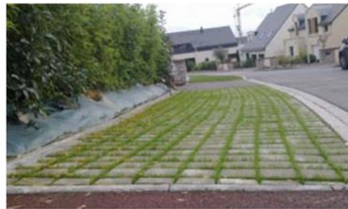
Emplacements de parking, St Grégoire
