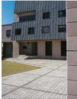
Accès de la caserne de pompiers, Colmar
