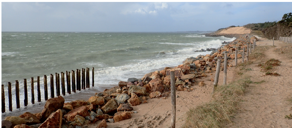
Figure 15 : La plage fortifiée des Eloux complètement recouverte par les vagues et la marée le 30 janvier 2015.
