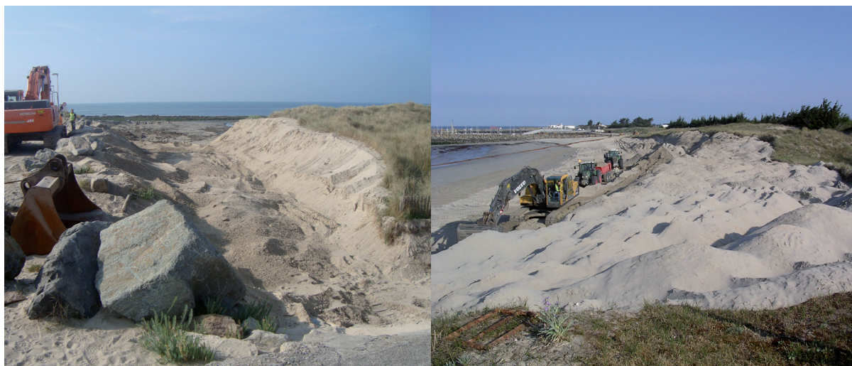
Figure 48 : Les opérations de transfert « mécanique » de sable depuis le nord du port du Morin (photo de gauche) jusqu'au plages en aval de la dérive littorale (photo de droite). Cliché de septembre 2009, Martin Paillart.
