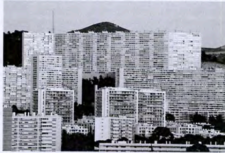
Figure 6 : Façade préfabriquée en béton, Quartier de la Rouvière, Marseille 9 ème arrondissement 6 (Architecte : Xavier Arsène-Henry)
