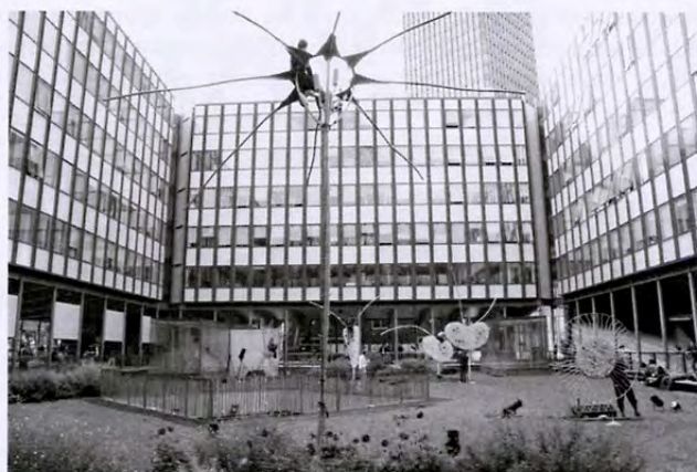
Figure 7 : Façade préfabriquée de l'Université de Jussieu, Paris 7 (Architecte : Édouard Albert, 1963-71)
