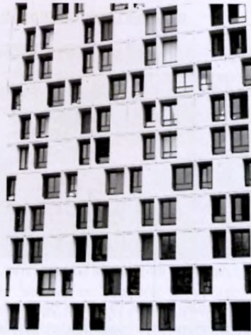
Figure 3 : Façade préfabriquée tramée d'un immeuble des trente glorieuses Quartier des Hauts de Bayonne 3
