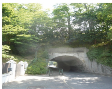
La Celle-Saint-Cloud (78) - Passage sous la voie ferrée
