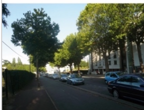
A Chatenay-Malabry, dans un contexte urbain dense, les immeubles sont de taille relativement haute. A gauche de la photographie, on devine les grilles d'un équipement sportif.
