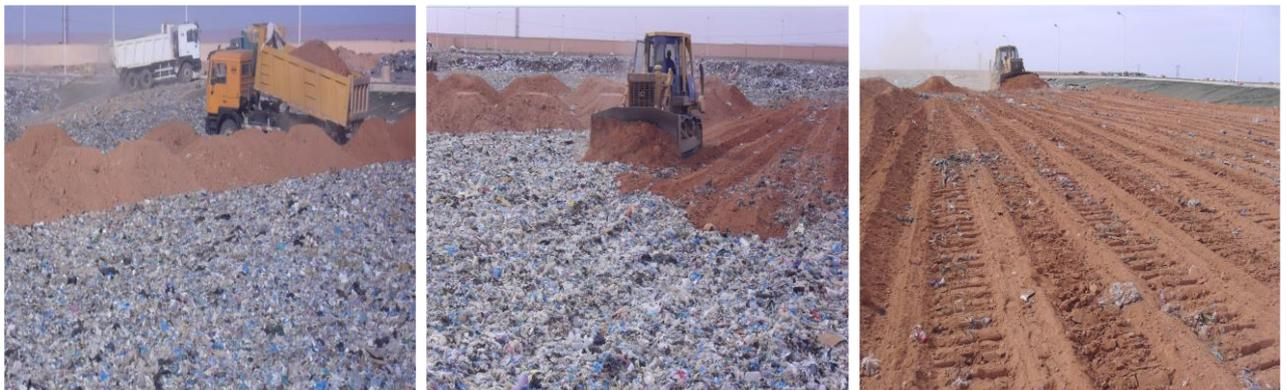
Figure 1:3 Préparation d'une couche de recouvrement – CET de Laghouat.
