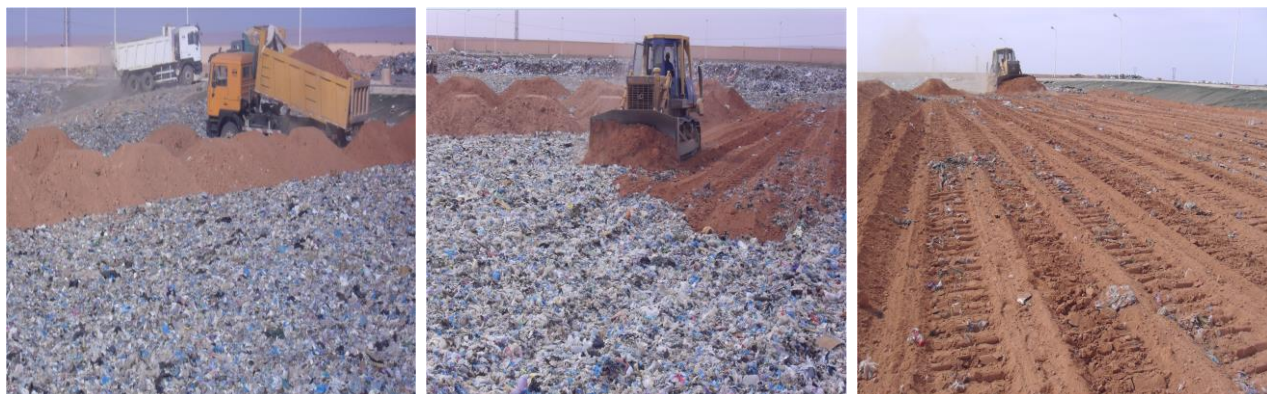
Figure 1:3 Préparation d'une couche de recouvrement – CET de Laghouat.
