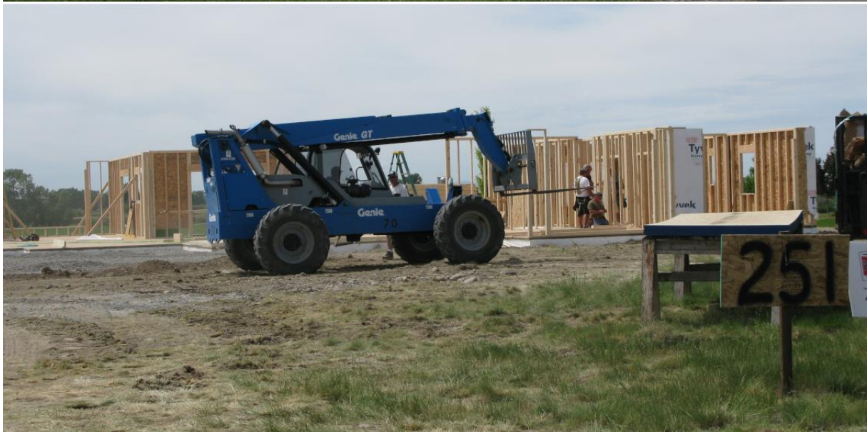
Photographie 25 : des paysages de la construction, à l’Ouest de Bozeman Bozeman, 12 juin 2014 (clichés G. Saumon)
