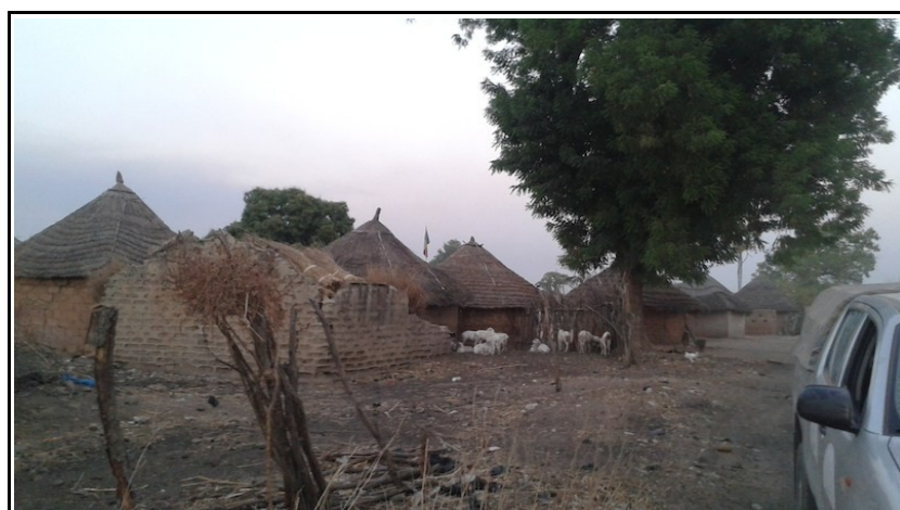
Figure n° 10 : Case du chef de village construite sur les ruines d'un bâtiment de la CCTA
