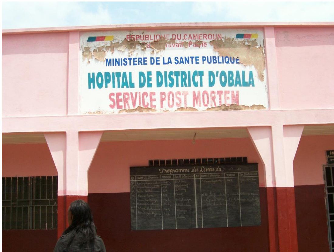
Figure 22 : façade principale de la morgue de l’hôpital d’arrondissement d’Obala
