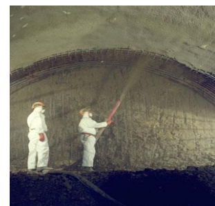
Revêtement d'un tunnel
