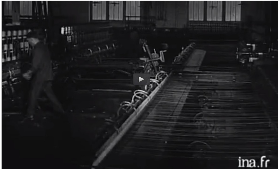
Illustration 15: Fabrication du fil par métier renvideur.
