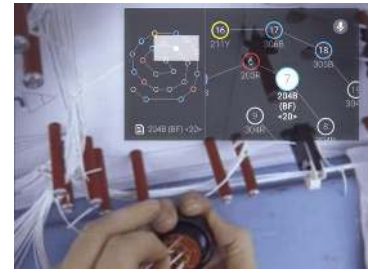
(c) Industrie : mise en place de la connectique d'un avion (Boeing)
