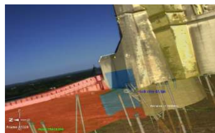
(i) Génie civil : suivi de chantier géotechnique (Raxenv)
