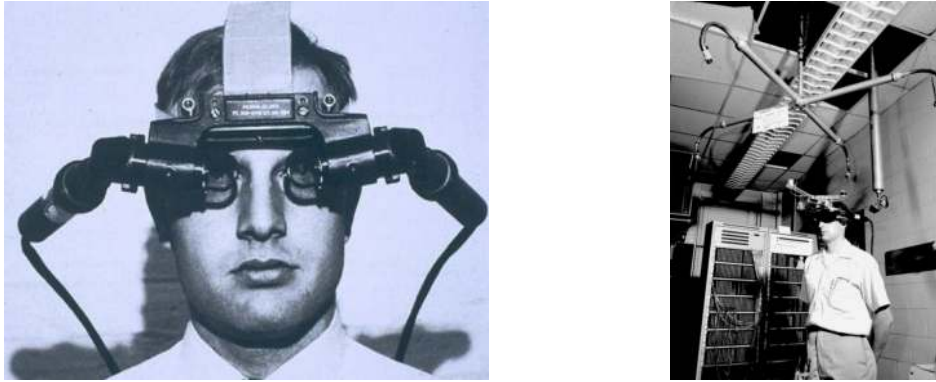
FIGURE 2.1 – Sword of Damocles , un des premiers prototypes de système de réalité virtuelle et augmentée [SUTHERLAND 1968]
