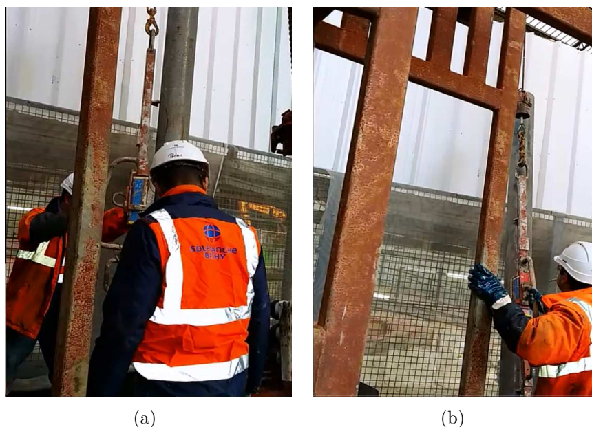
FIGURE 1.10 – Des ouvriers lors de la manutention d'une tige de forage pour une opération de chargement sur la machine
