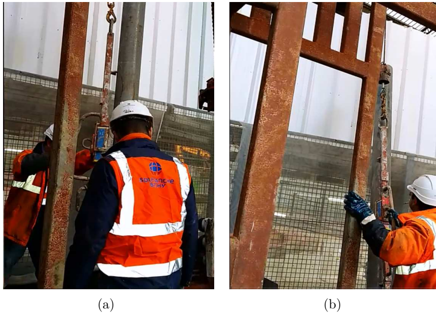
FIGURE 1.10 – Des ouvriers lors de la manutention d'une tige de forage pour une opération de chargement sur la machine
