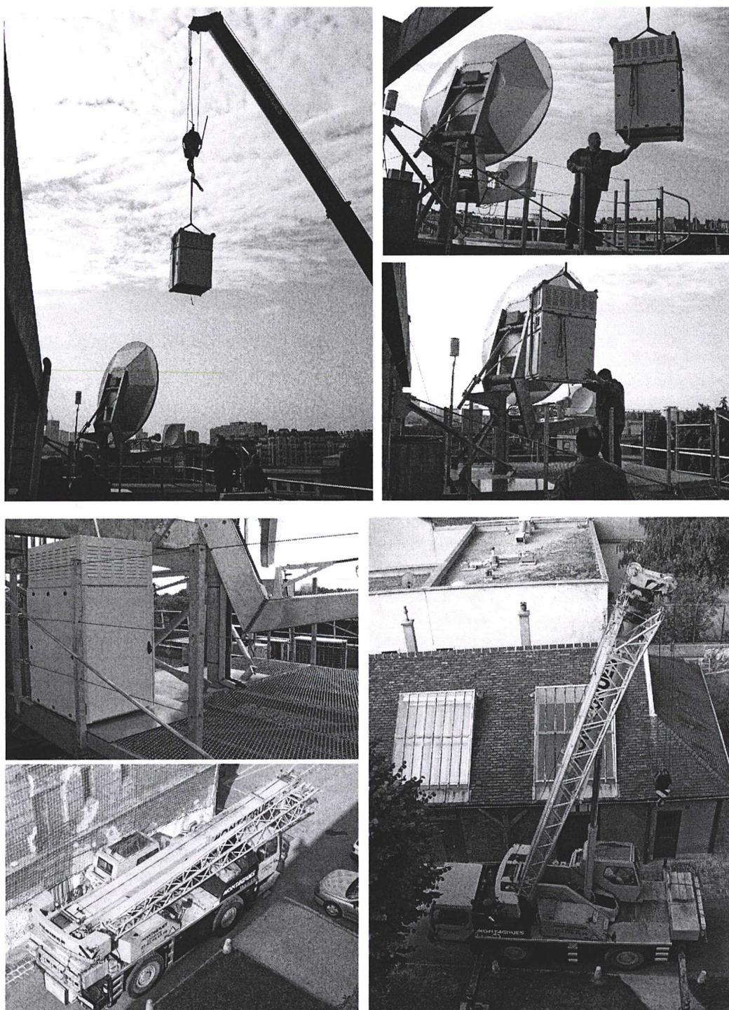
\*\*\* Figure 6.27 : installation de l'enceinte régulée en température \*\*\*
