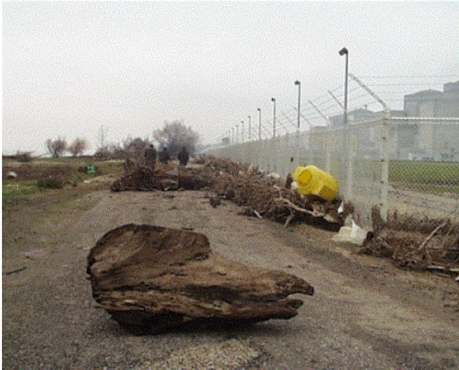
Figure 59 : Site du Blayais après l'inondation (IRSN, 2000)
