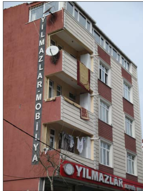
Sur les balcons de cet immeuble, protégées dans des placards, des chaudières individuelles à ventouse ont été installées.
