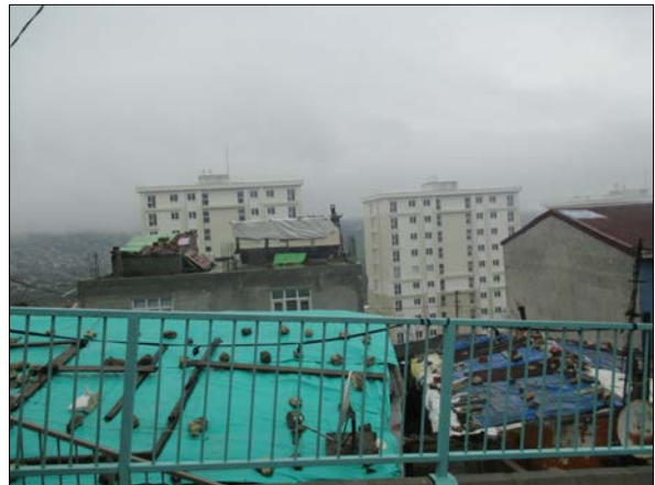
Maintenues par des pierres et des planches de bois, des bâches plastiques recouvrent le toit de deux gecekondus . En arrière-plan, les deux tours du programme immobilier « Kaya City » présagent l'avenir du quartier une fois accompli le projet de transformation urbaine.
