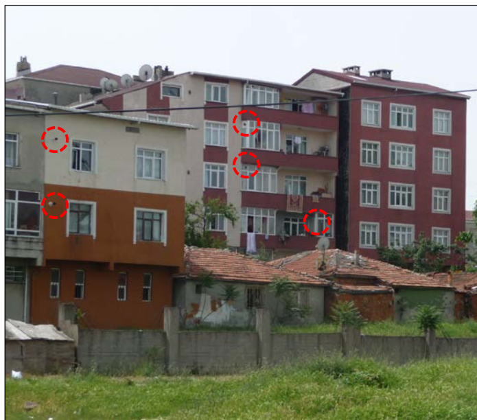
Des gecekondu chauffés au charbon aux immeubles auto-construits équipés de chaudières à gaz dans le quartier Ziyah Gökalp. Crédit : E.A., 17/05/2013
