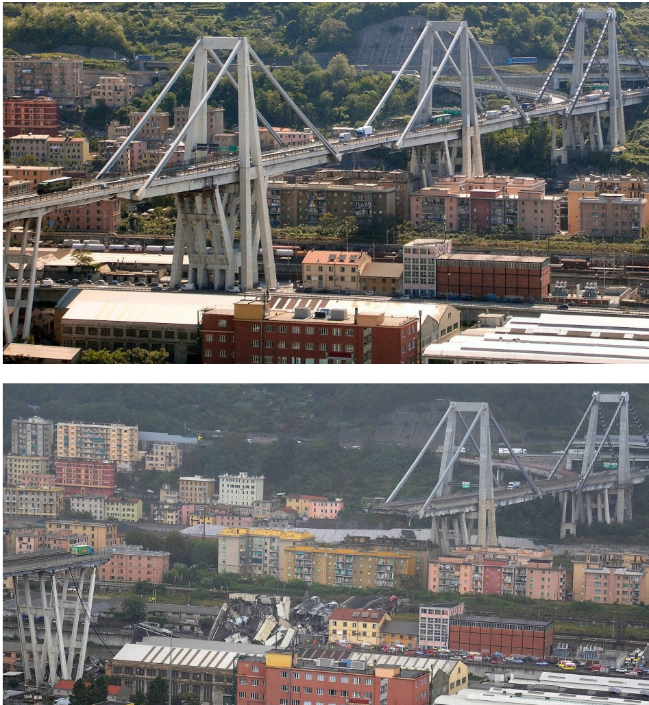
FIGURE 1.6 – Effondrement du pont Morandi à Gênes en Italie (2018)
