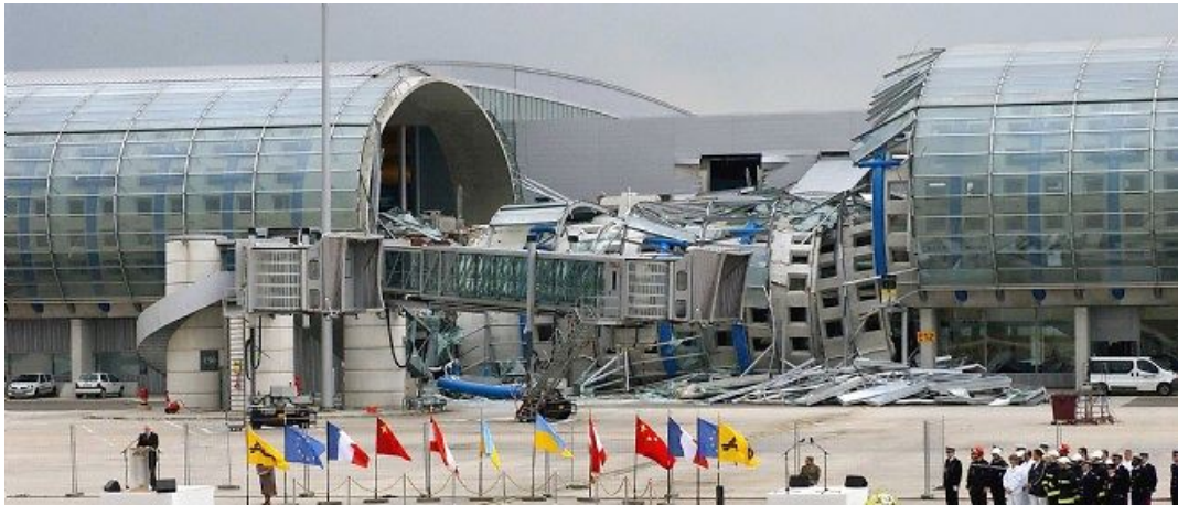
FIGURE 1.7 – Effondrement du terminal de Roissy en France (2004)
