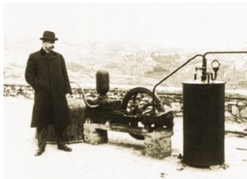
Figure 3 : Photographie de la première installation géothermique et de son inventeur Prince Piero Ginori Conti, Italie, 1904 (Dickson et Fanelli, 2004)
