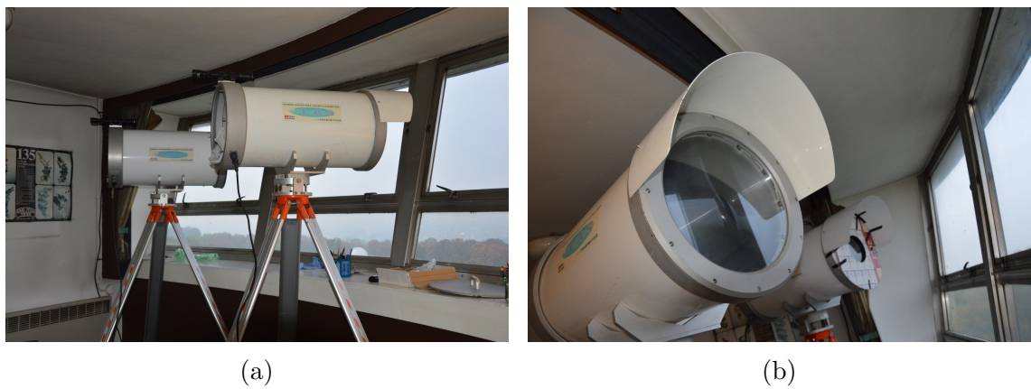
FIGURE 4.2: Installation des scintillomètres côté observatoire de Meudon.
