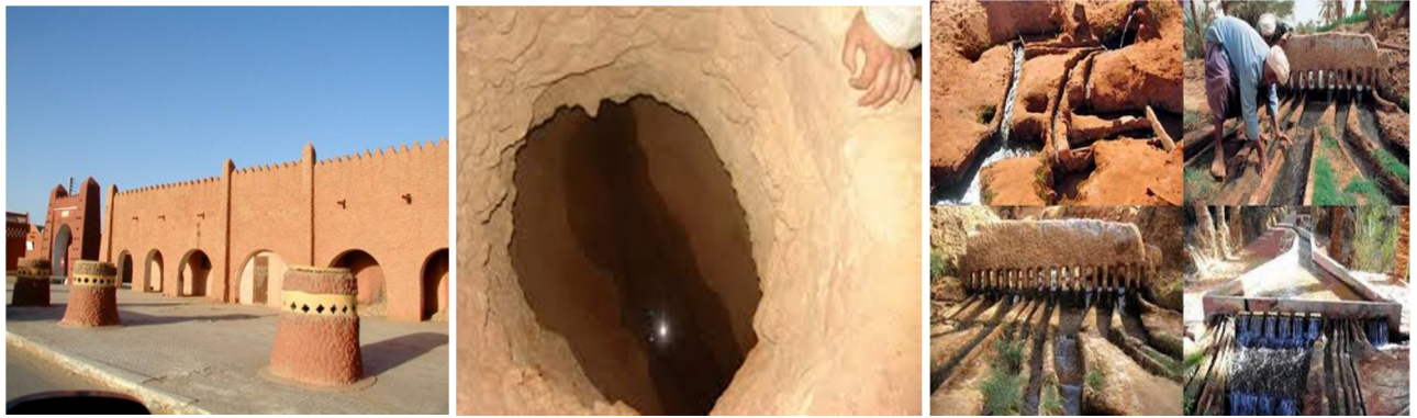
Fig. I.13 : Système d'irrigation « El_foggara » dans la région d'Adrar.
