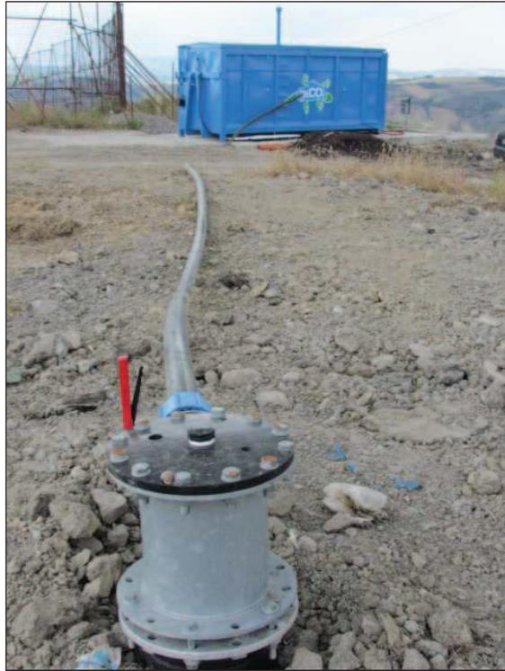
**Figura 7.14** – Pozzo di biogas con collegamento al biofiltro
