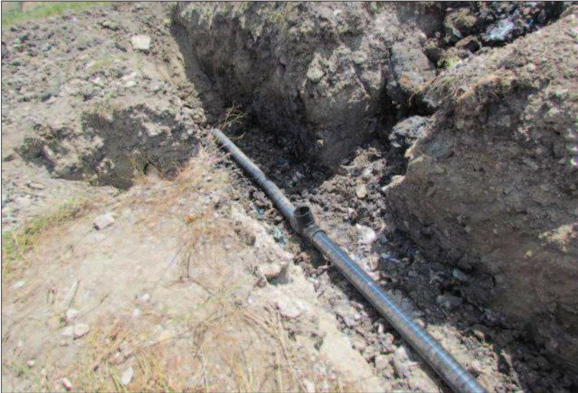
**Figura 7.13** – Tubo in PVC fenestrato per la captazione del biogas
