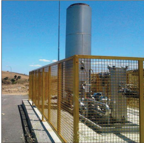
**Figura 7.18** – *Torica statica per il trattamento del biogas – Venosa (PZ)*
