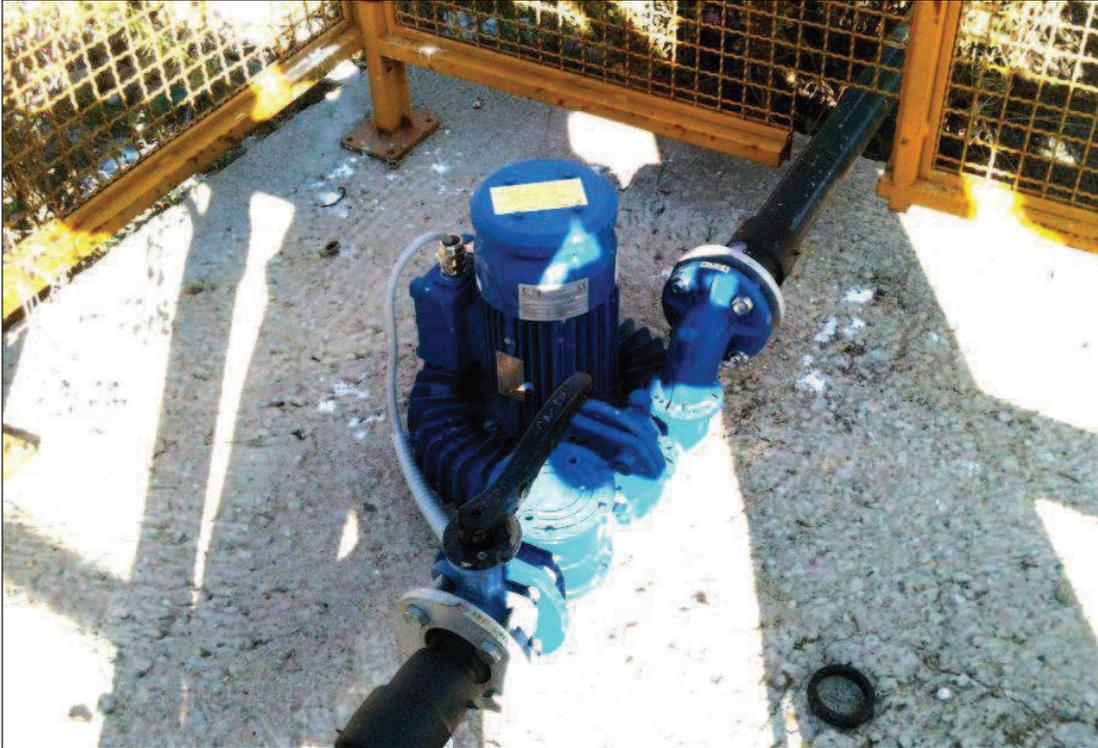
**Figura 7.20** – *Soffiante per l'aspirazione del biogas*
