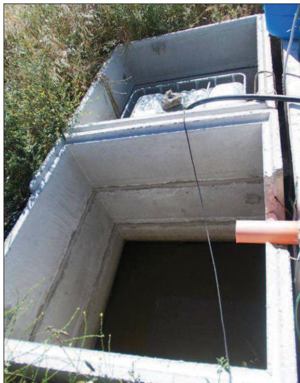
**Figura 7.15** – Vasche in calcestruzzo per l'acqua di bagnatura IN & OUT
