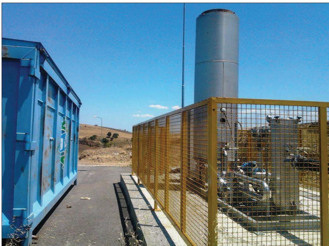
**Figura 8.1** – Torcia e biofiltro presso la discarica di Venosa (PZ)
