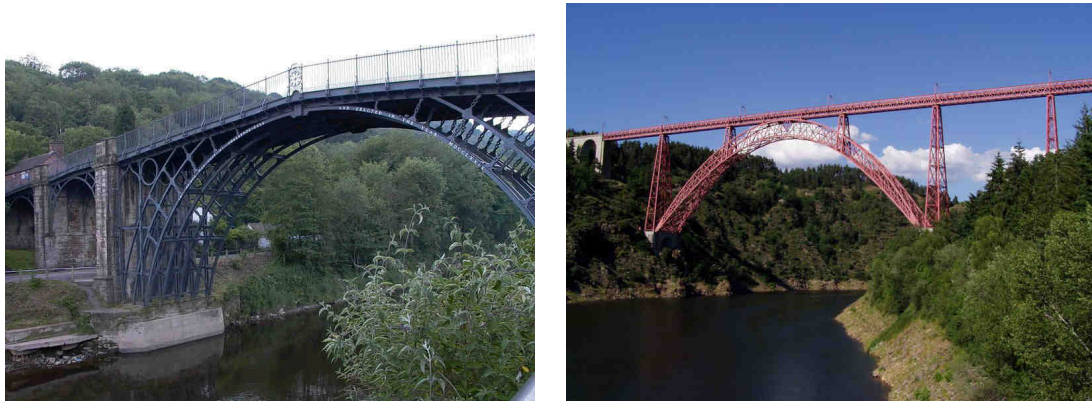
Figure 1.9 – A gauche : Pont de Coalbrookdale (1779, Shropshire, Angleterre, Royaume-Uni), construction de type pont en arc métallique, dont la géométrie est de genre «tresse creuse» (Copyright Pr. Michael Littman/Structuræ). A droite : Viaduc de Garabit (1864, Ruynes/Saint-Flour, Cantal, Société Gustave Eiffel & Cie), d'une longueur de tablier de 565m, permettant la traversée des Gorges de la Truyère (affluent du Lot).
