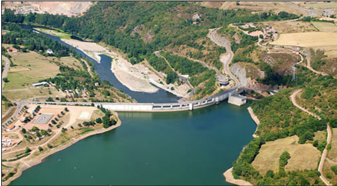
Figure 97: le Barrage de Villerest. Situé à Villerest en amont de Roanne, il s'élève à 55 m au-dessus du lit du fleuve entre deux parois rocheuses et s'étend sur 420m de longueur. La superficie de sa retenue est de 760 hectares en période normale et de 2 300 hectares en période de retenue maximale. Sa capacité totale est de 166 millions de mètres cubes.
