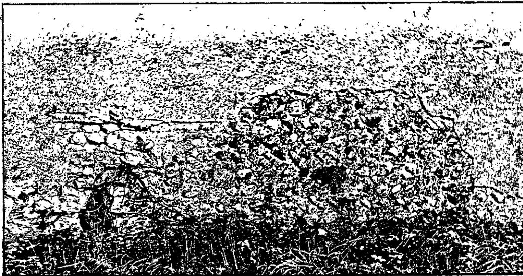
FACADE OUEST : maçonnerie de galets sous l'enduit
