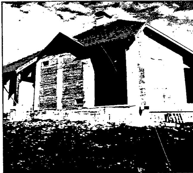
Figure 60 : La terre support des mythes ; Maison solaire passive avec des murs de pisé dans une structure béton. (photo : CAUE des Landes).
