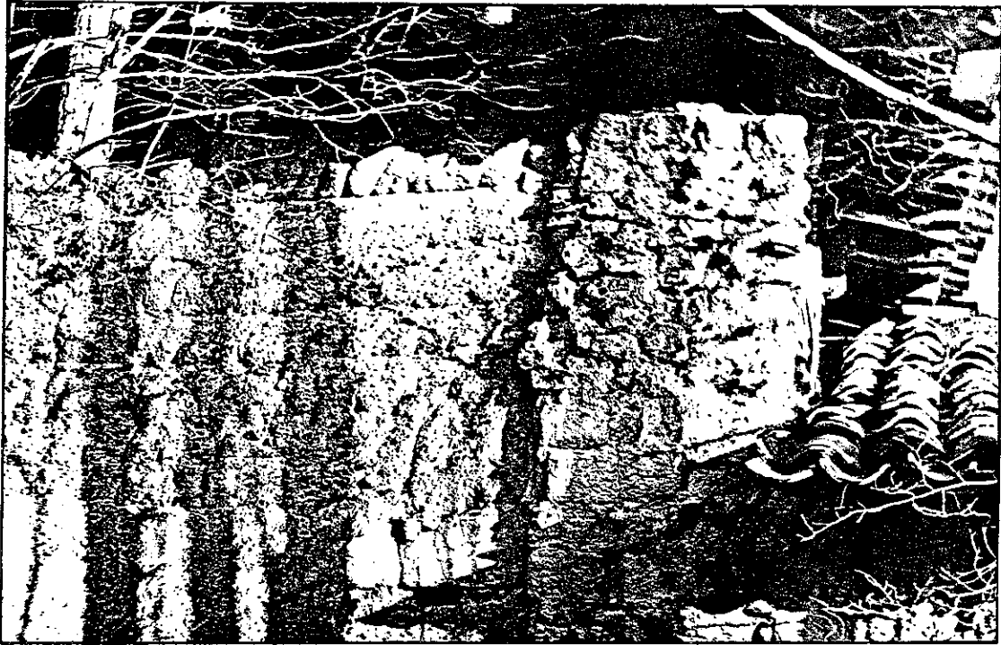
FACADE OUEST : briques de terre moulées et façonnage direct
