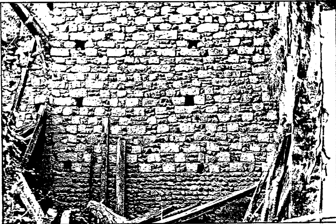
19.2 GRANGE A ST. OST : appareillage en damier de briques de terre non moulées et de galets sur soubassement de galets liés au mortier de chaux. Les percements sont des boulines.
