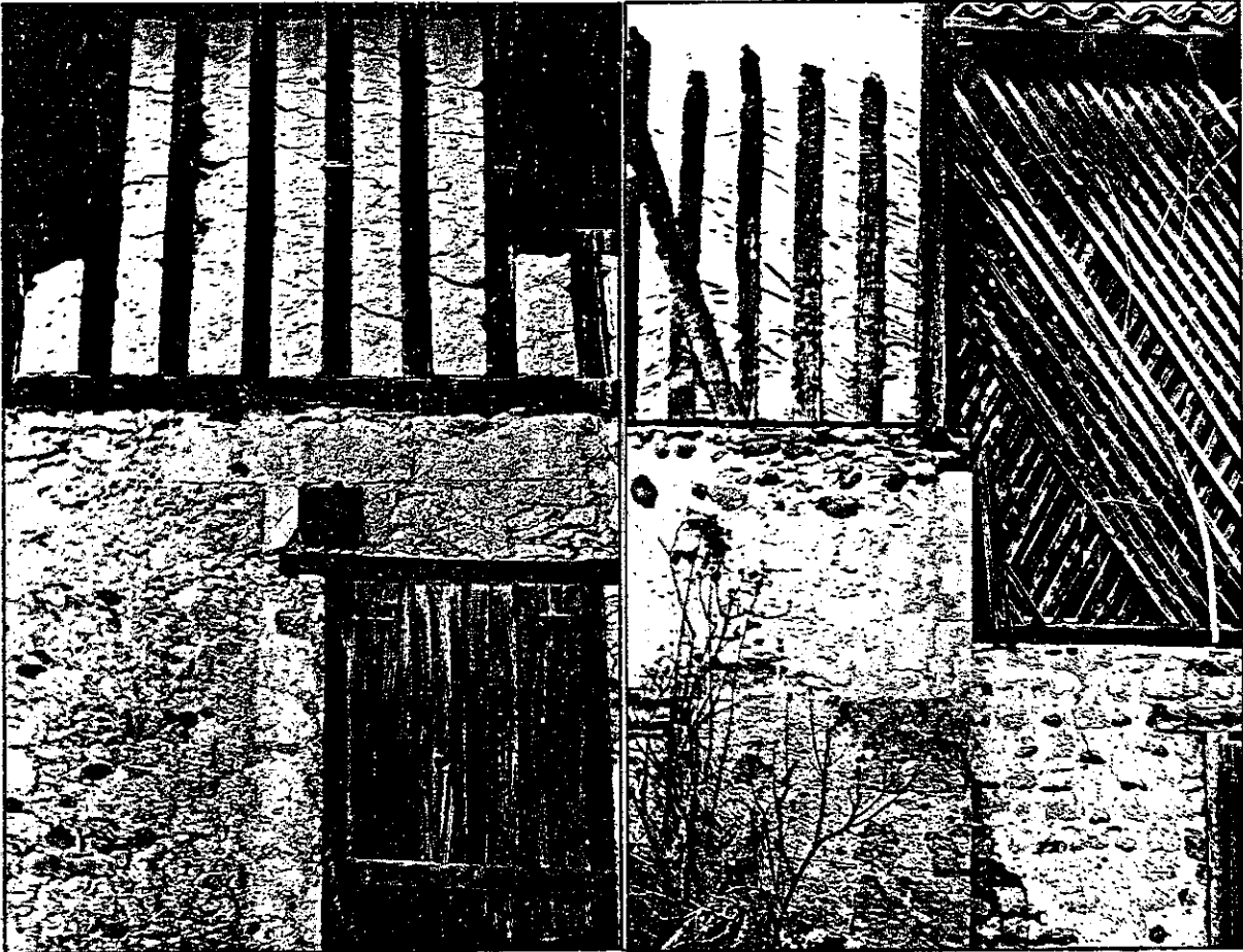
FACADE EST (COUR)
