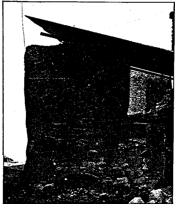
Fig. 8 : Angle de mur à Byrsa. 1: pisé; 2: briques de terre
