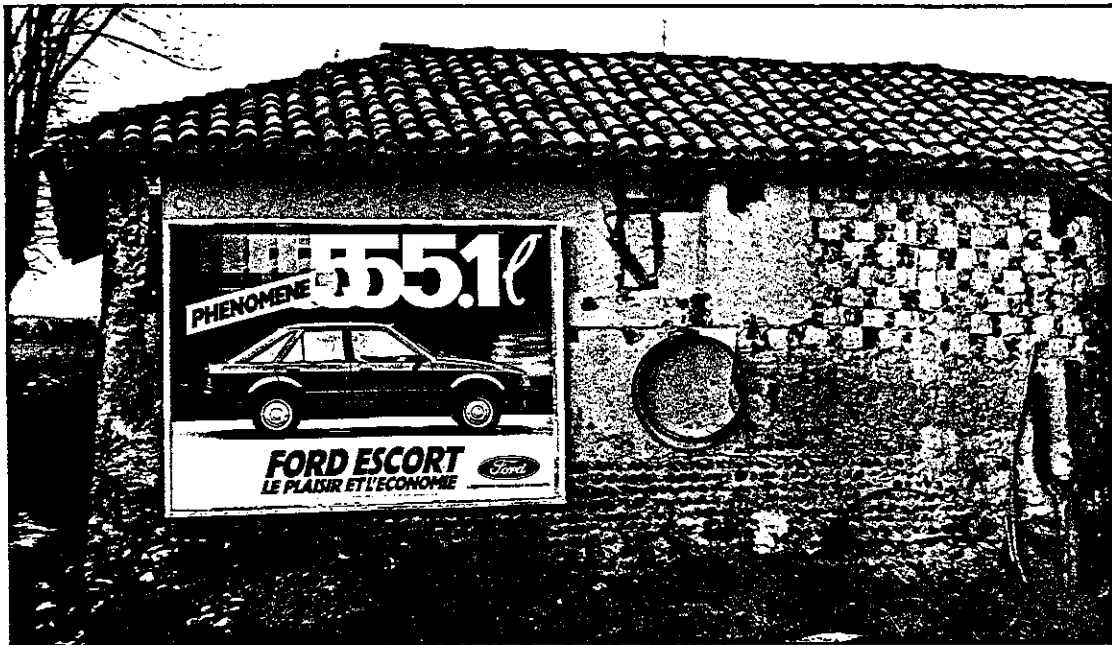
FACADE SUD : soubassement de galets/pisé/colombage hourdé de terre/appareillage en damier de briques de terre et galets.
