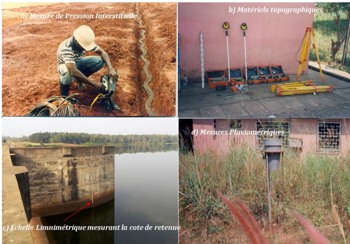
Photo 14 – Les mesures d’auscultations sur le barrage de Boali. Source: ENERCA.
