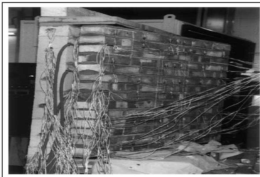
Figure 5. Construction d'un prototype de double mur à épaisseur variable de la lame d'air (Aviram et al. 2001)
