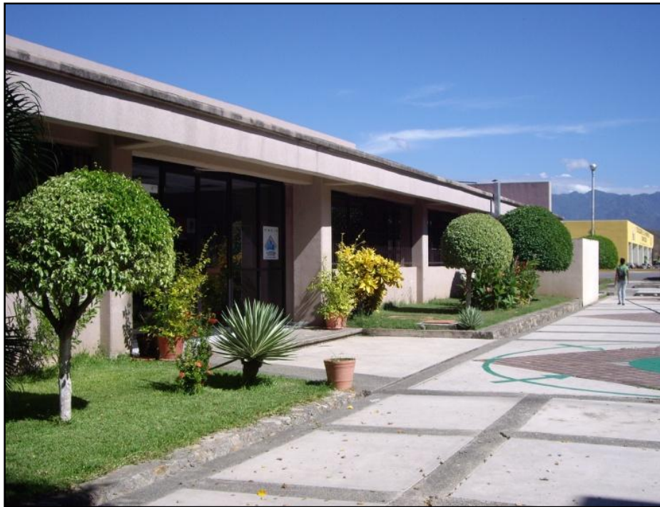
Fotografía 5.4: Entrada del edificio del Departamento de Turismo. Es el edificio ubicado el más al norte en la fotografía satelital 5.3. (Lariagon R., 2011).
