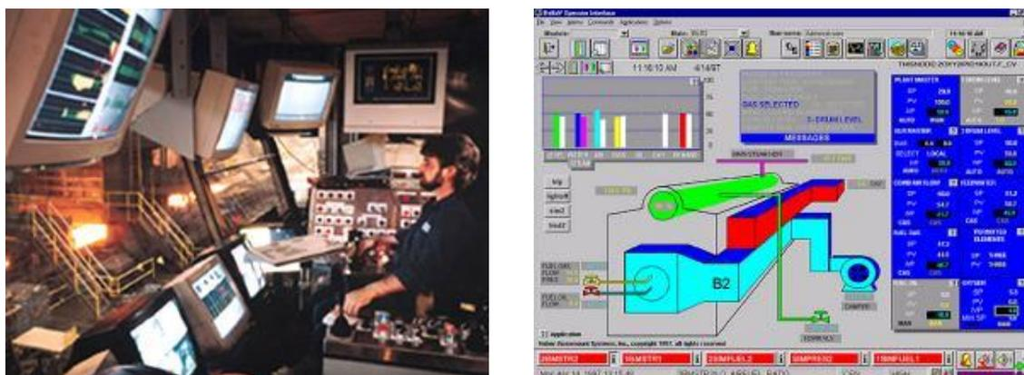
Figure 1.2 : (a) poste de supervision (b) exemple d'Interface Homme-Machine
