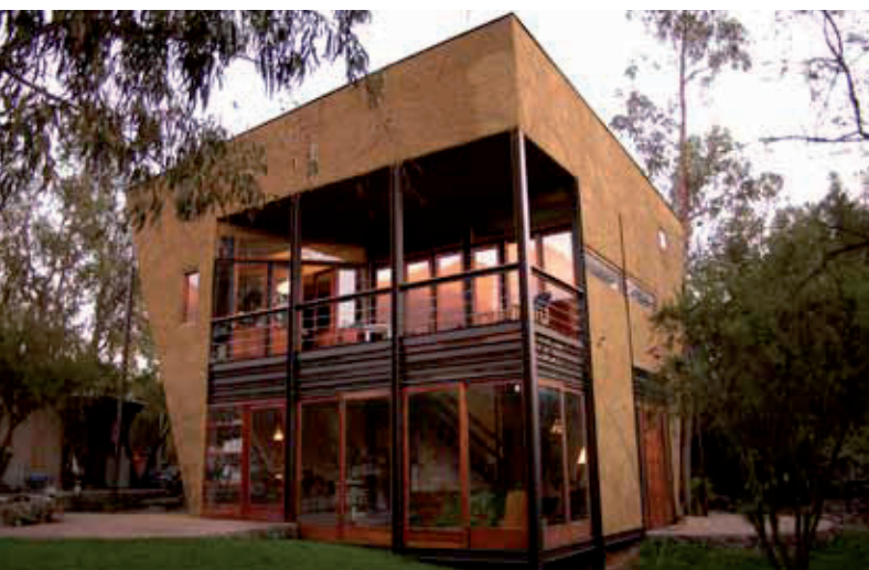
Image 6 : Construction en ossature métallique et torchis réalisée par l'architecte chilien Marcelo Cortes. © M. Cortes
