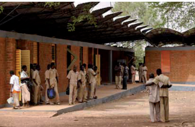
Image 8 : École secondaire dans le village de Dano, Burkina Faso, architecte Francis Kere. © F. Kere
