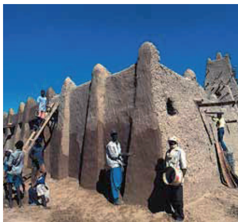
Formation de maçons, Tombouctou, Mali, 1996
