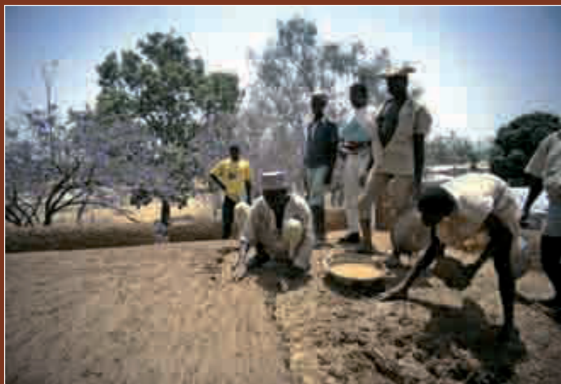
FIGURE 6 Réfection de l'enduit de toiture, église St.-Barthelemy, Zaria, Nigéria.
