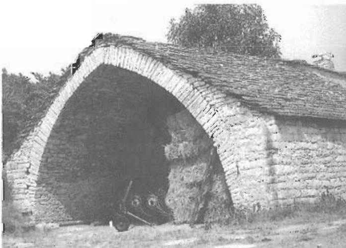
Grange bâtie en pierres et couverte de lauzes, Causse Méjean, France.
