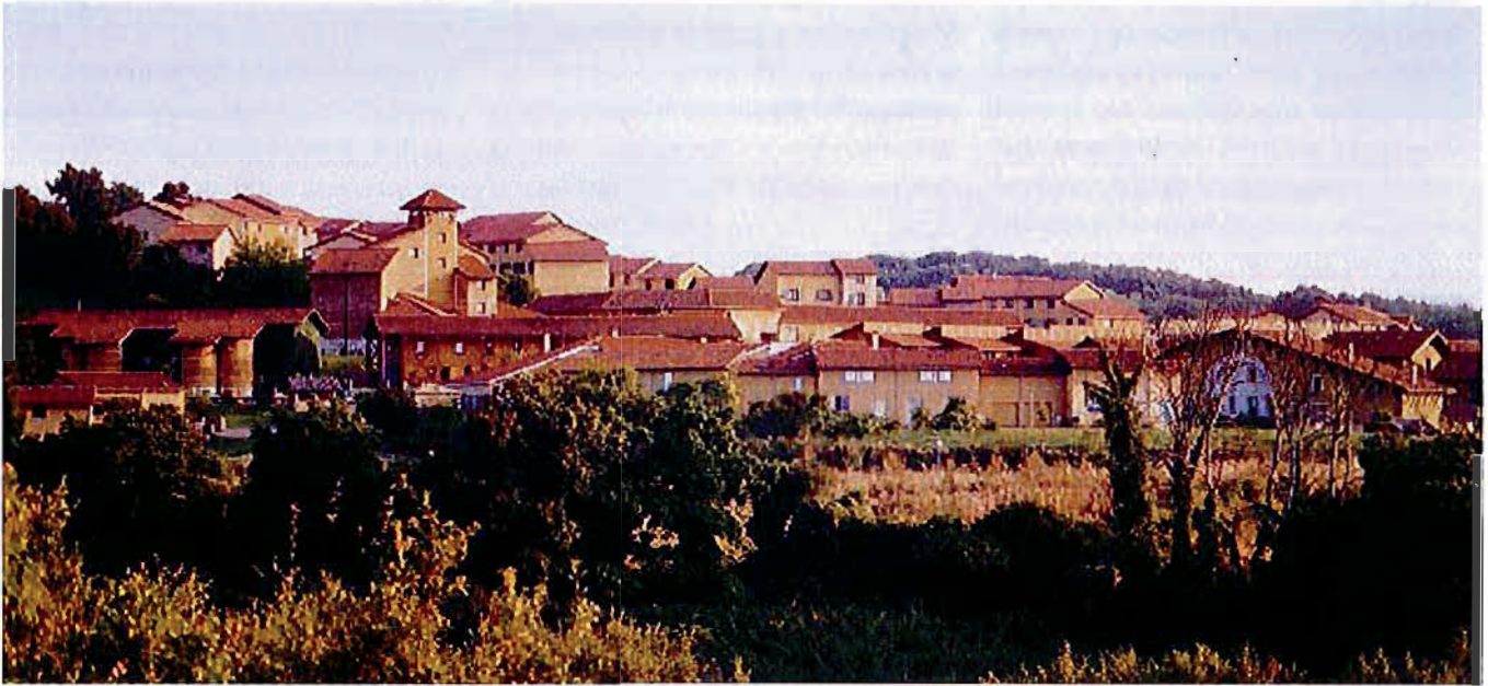
Le Domaine de la Terre à Villefontaine (Isère). Cet ensemble de 65 logements a été construit par l'OPAC (Office public d'aménagement et de construction) de l'Isère et l'EPIDA (Expérimentation de parcours d'insertion à durées adaptées) en 1984-1985, avec le soutien du Plan construction et l'assistance technique de CRATERRE. En 2008, cet ensemble a été classé parmi les 45 "Trésors du développement durable" de la région Rhône-Alpes.
