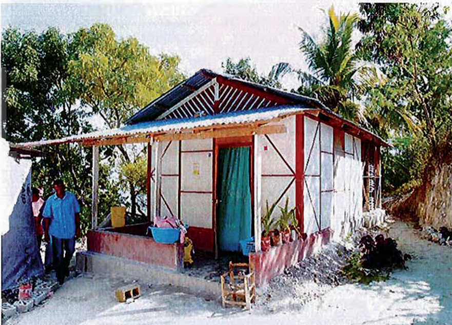
Un des prototypes de maison de base du projet de reconstruction à Haïti. Sur l'exemple des premiers prototypes et en collaboration avec différents partenaires, une méthodologie de reconstruction a été définie, fondée sur un système traditionnel d'entraide : le kombit . En l'espace de quatre années, plus de 3000 unités d'habitation ont pu être reconstruites ou réparées. Le même principe constructif, validé par le ministère des Travaux publics, sert aujourd'hui pour la construction d'écoles à un étage.
