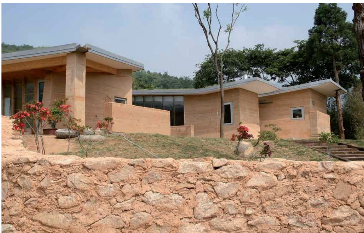
Image 10 : Maison d'un ancien chef de l'État de Corée du Sud, projet de l'architecte Chung Gu-Yon et Guyon architects, bâtie en pisé par l'architecte entrepreneur Shin Gueun Shik. © Shin Gueun Shik
