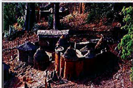
Des tours-greniers en construction et des takyélenta (maisons traditionnelles) en pays batammariba, au Nord du Togo. La technique du façonnage direct de terre plastique est certainement une des plus anciennes. Ce n'est pas pour cela qu'elle n'est pas sophistiquée. Ici, les murs, qui s'élèvent jusqu'à 5 mètres de hauteur environ, ne font pas plus de 15 centimètres d'épaisseur à leur base et s'affinent vers le haut. Une logique parfaite, digne des meilleurs calculs de structure que l'on pourrait faire aujourd'hui.
