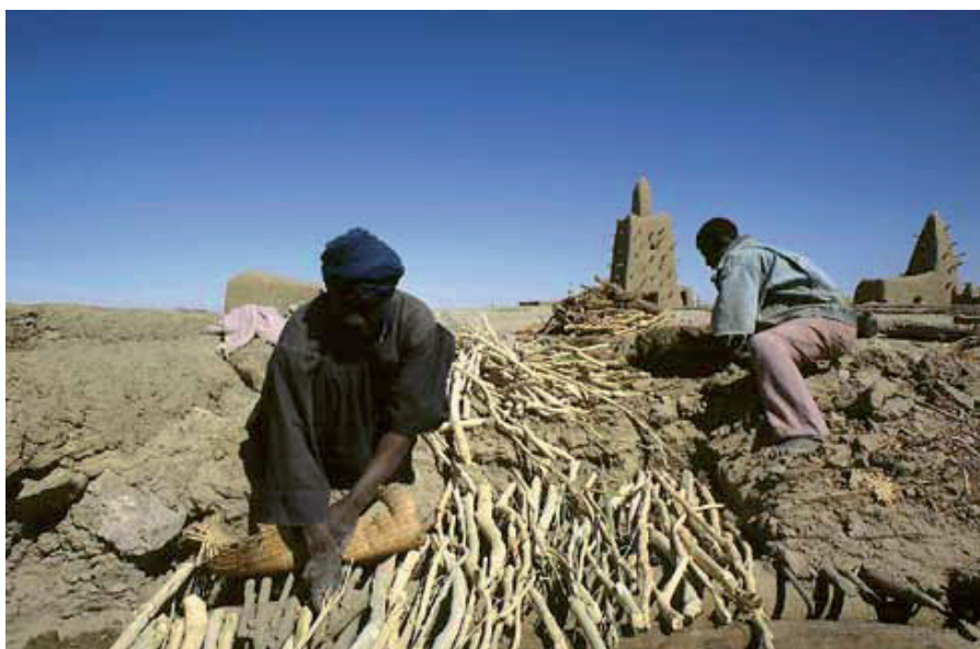
Formation de maçons, Tombouctou, Mali, 1996
