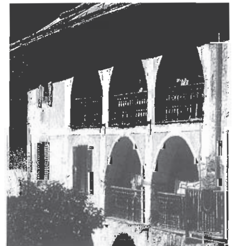
Ferme bâtie avec plusieurs niveaux de voûtes d'arêtes, Queyras, France.
