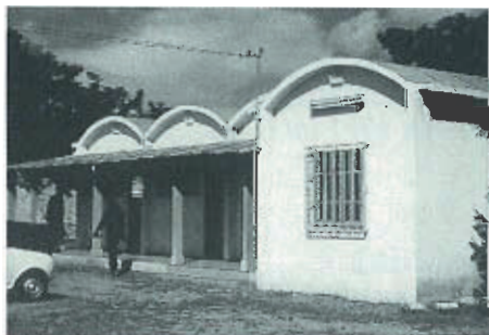
Centre de recherche à Dakar, Sénégal.
