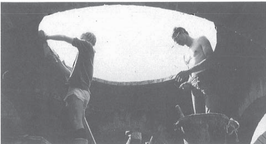
Construction d'une coupole par assises tronconiques.
