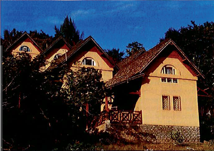
Petit lotissement à Mamoudzou (Mayotte). Après des premiers prototypes d'habitat, un grand programme d'habitat social a pu être lancé par la Société Immobilière de Mayotte, avec l'appui technique de CRATERRE pour la mise au point des matériaux (BTCs), la mise en place de briqueteries et la formation des acteurs (maçons, chefs de chantier, architectes). Ce programme Immobilier comprendra des logements à la location, puis des réalisations publiques (écoles, collèges...) et privées.
