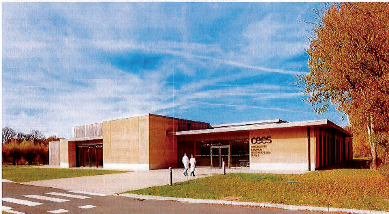
Le Centre (Institut national de la recherche agronomique) Val de Loire à Ardon, près d'Orléans. Le Conservatoire européen des échantillons de sols, construit en 2014 pour l'INRA Val de Loire à Orléans, a été conçu par les agences Design & Architecture et Nama Architecture. Destiné à analyser et conserver plus de 30000 échantillons de sols venus de toute l'Europe, ce bâtiment a été construit en pisé. Cette technique s'est imposée pour sa capacité porteuse et ses propriétés hygrothermiques et esthétiques. Les murs extérieurs, exposés aux intempéries, ont été stabilisés avec 5 % de chaux. Ils ont été réalisés par les entreprises Hellopsis et Caracol, spécialisées dans la construction en terre depuis plus de dix ans.
