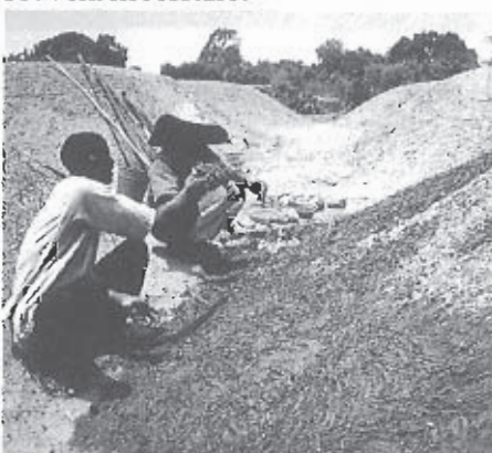
L'enduit de terre est efficace mais nécessite un entretien régulier.
