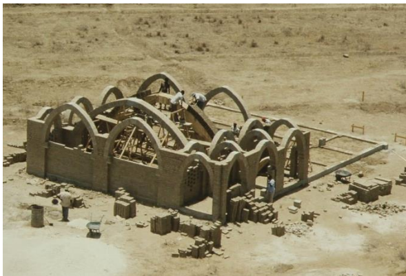
Ecole de Djenale en Somalie: vue du système constructif en cours de réalisation et deux premiers blocs terminés
