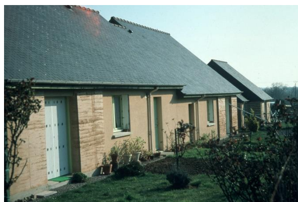
Mise au point du système de banchage pour la réalisation des logements HLM à Romillé (à droite)
