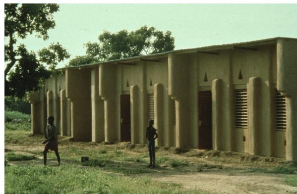
Ecole de Yagma, chantier formation
