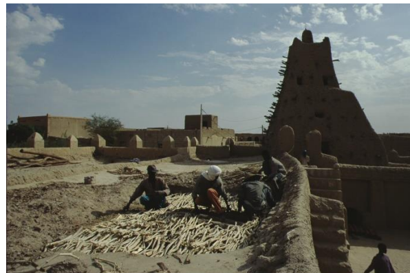
Réfection de la toiture de la mosquée de Sankoré
