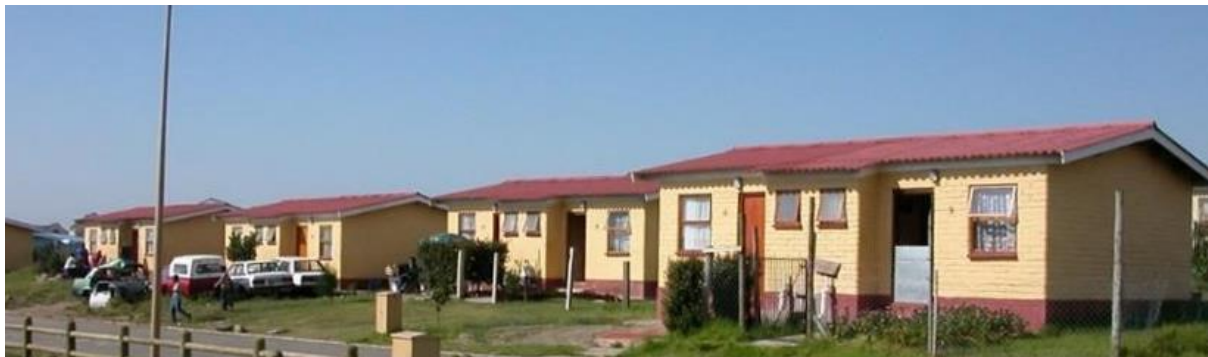
Unités d'habitation en lotissement du projet mené en Afrique du Sud avec la Van der Leij Foundation
