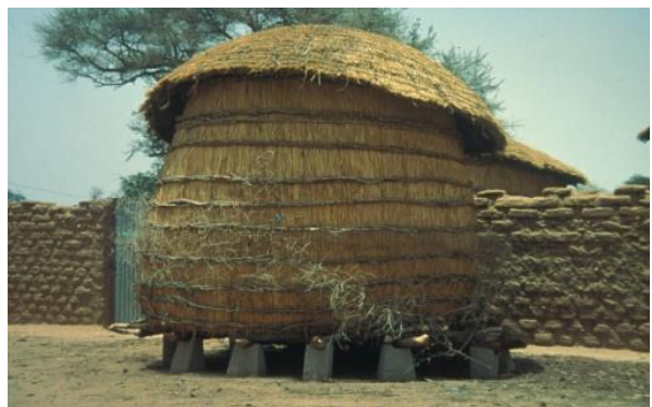
Substitution des piliers en bois par des potelets en béton
