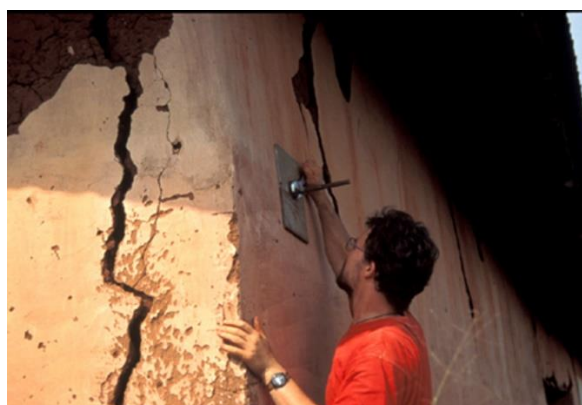
Travaux de maintien par tirant
