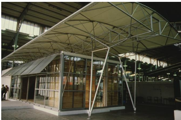
La Maison du futur, La villette
