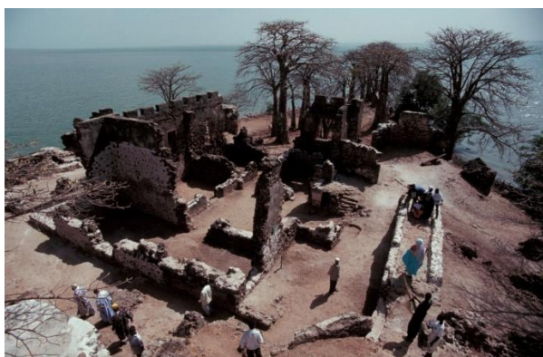
Vue générale du chantier de restauration
