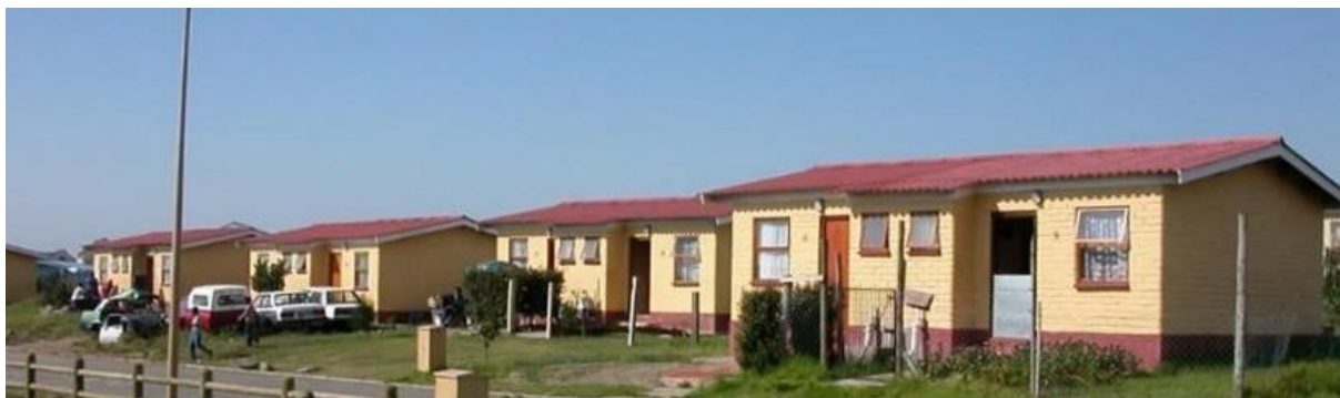
Unités d'habitation en lotissement du projet mené en Afrique du Sud avec la Van der Leij Foundation
