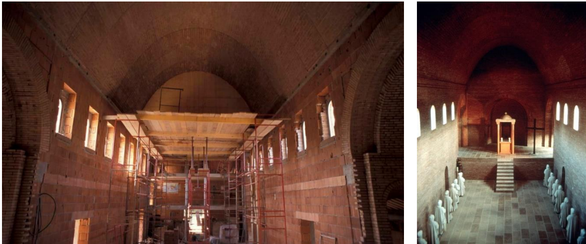
Voûte de l'église des petites sœurs de Bethléem, Le Thoronet : construction en 1997 et au cours d'un office
