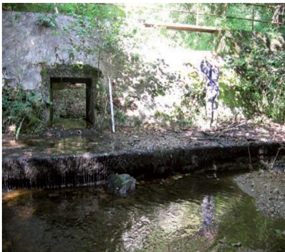
Photo n°15 : Vue aval du site avant travaux en 2011 (SMPVD)
