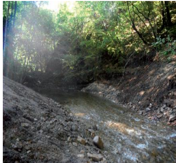
Photo n°16 : Vue aval du site après-travaux en 2013 (SMPVD)
