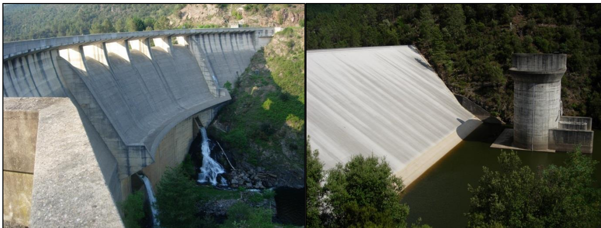
Photo 1: à gauche : barrage écrêteur de crues et de soutien d'étiage de Sénéchas, sur la Cèze, à sa confluence avec l'Homol ;
